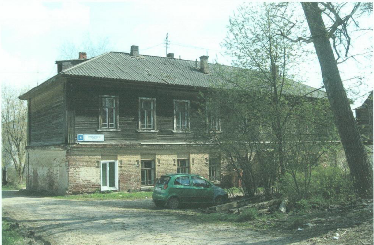
Фото 1. Общий вид с улицы Урицкого, с северо-запада.
