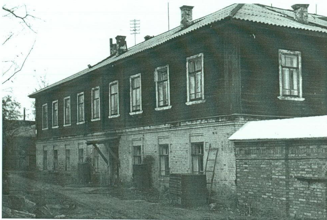
Юго-западный корпус (ул. Урицкого, 4). Западный фасад (по улице Урицкого). Октябрь 1989 г., Талантов Г.Б., КСНРПМ.
