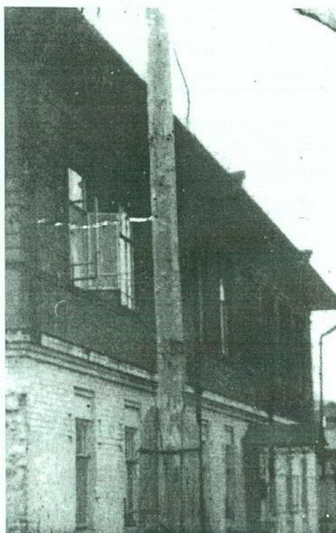
Юго-западный корпус (ул. Урицкого, 4). Фото 1960-х гг.
