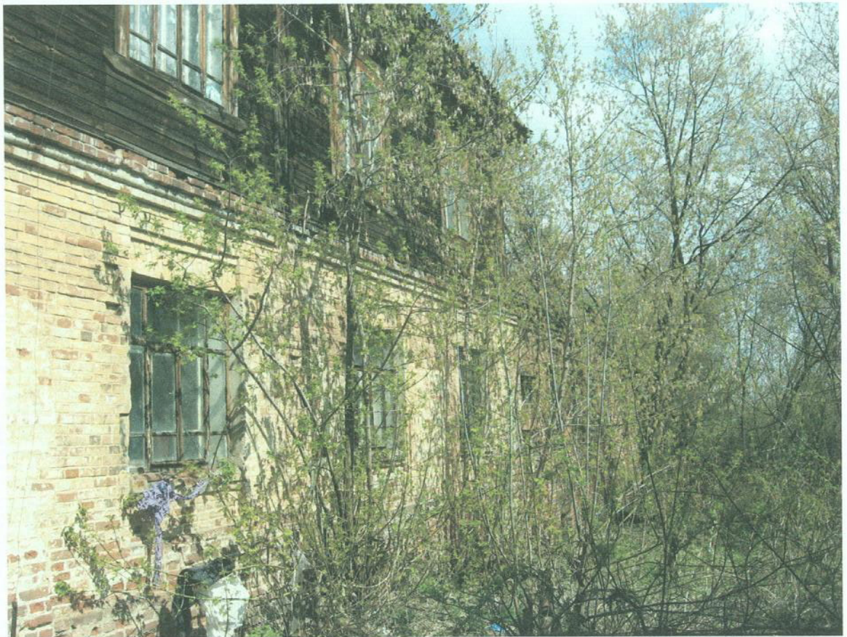
Фото 7. Восточное крыло. Южный фасад.
