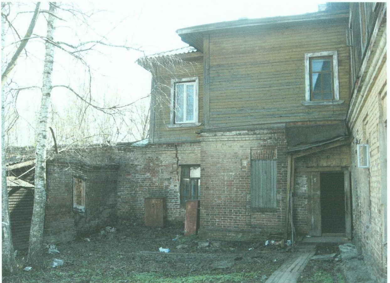
Фото 4. Восточное крыло. Вид со двора.
