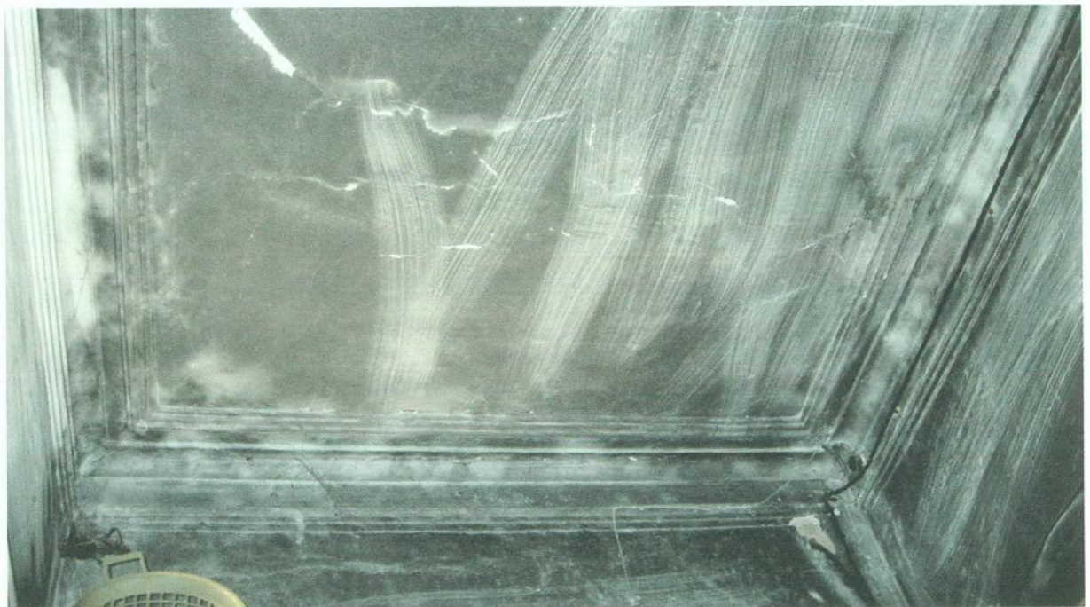
Фото 8. Интерьер. Северное крыло. Лестничная клетка. Штукатурный карниз.
